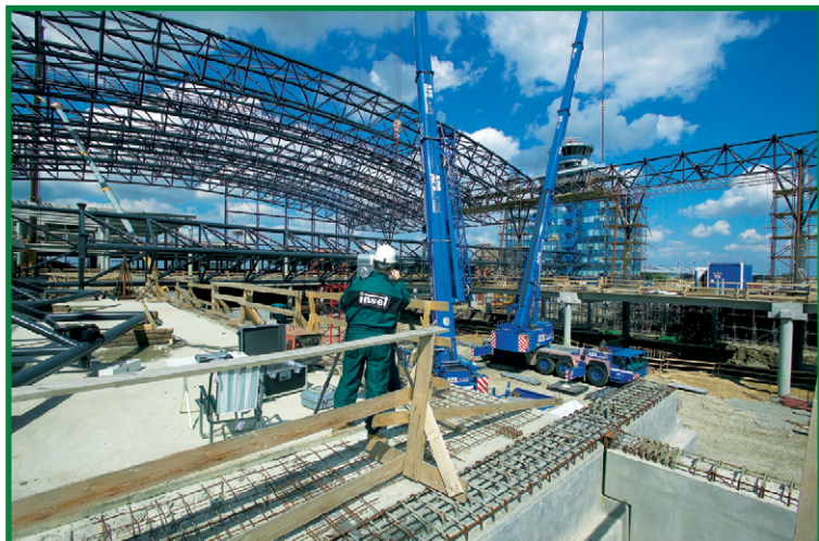
výstavba terminálu „Sever“ letiště Praha - Ruzyně
