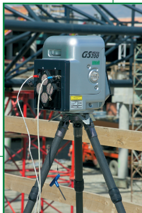
podrobná kontrola přesnosti montáže nosné konstrukce střechy
